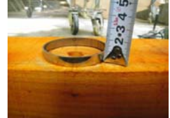
スプリットリング施工状況1
