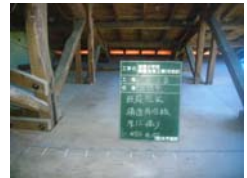
陸梁上構造用合板施工状況
