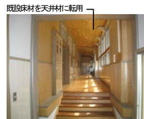
耐震改修後廊下1
