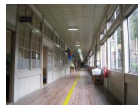
耐震改修前廊下
