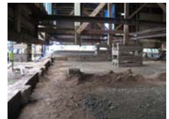
特別教室棟上げ屋状況
