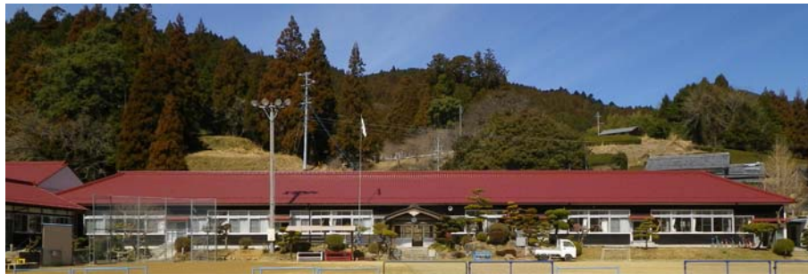
耐震改修後概観
