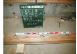
スプリットリング施工状況2
