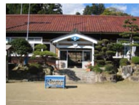
耐震改修前玄関
