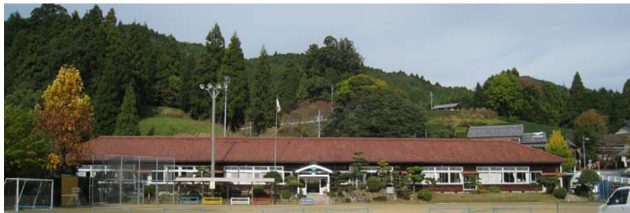
耐震改修前概観
