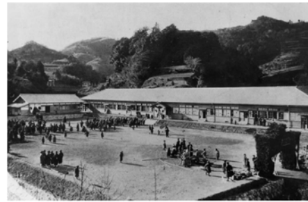
1927年竣工時写真
