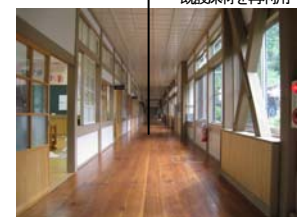
耐震改修後廊下2
