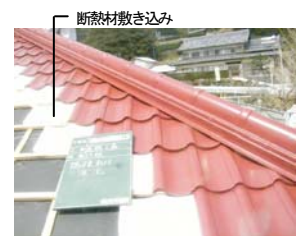
屋根材施工状況
