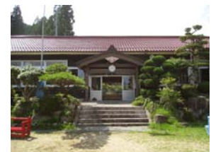
耐震改修後玄関
